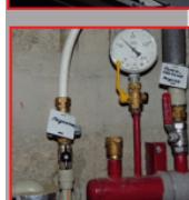
До начала розжига котла открыть линию подпитки системы отопления и контрольную линию заполнения расширительного бака. Убедиться, что давление по манометру, установленному на котле, не растет.
